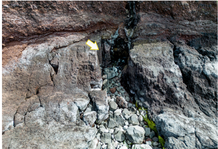
Pormenor do local onde pensamos estaria a fenda por onde se entrava para recolher a água.
