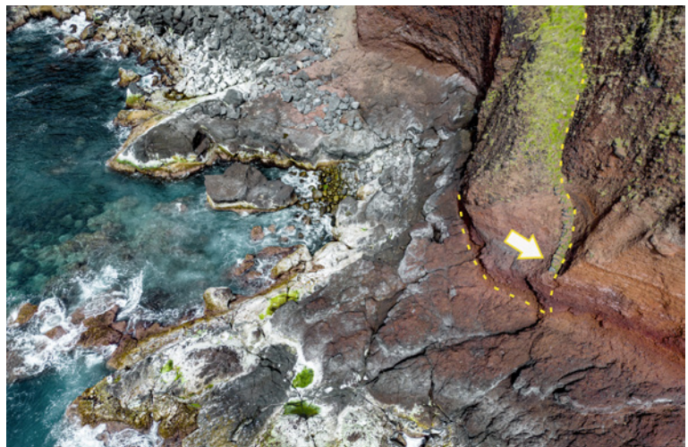
Outro pormenor da descida da Água Azeda da Serreta. A seta não assinala a nascente, mas o que ainda resta da escadaria em pedra desta descida.
