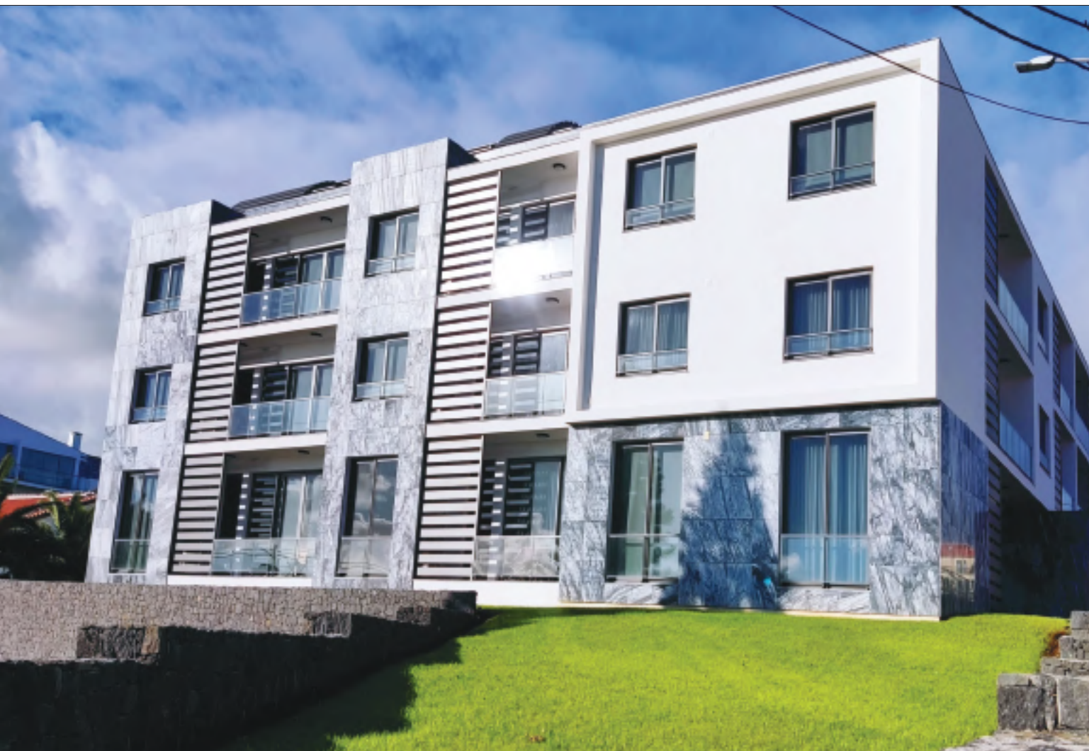
Construção de empreendimento privado em Praia da Vitória
