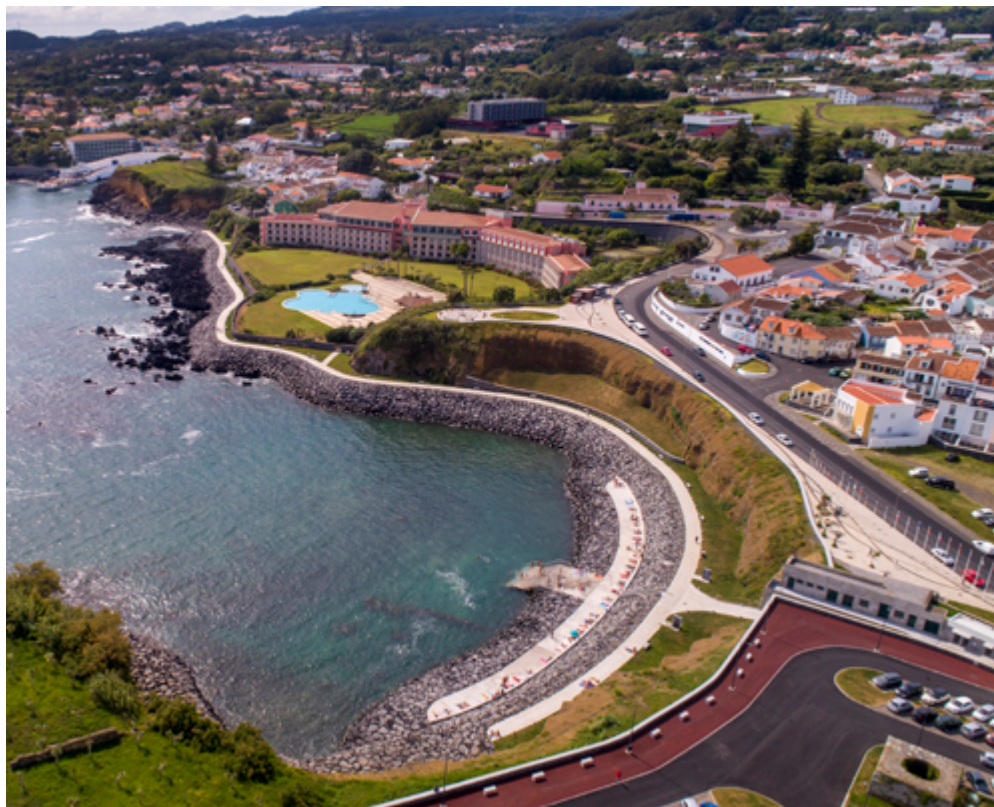
Foto 18 – Fanal, após as obras de remodelação. CMAH
