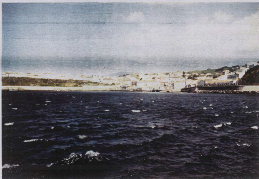
VUE NORD-OUEST DE LA VILLE
