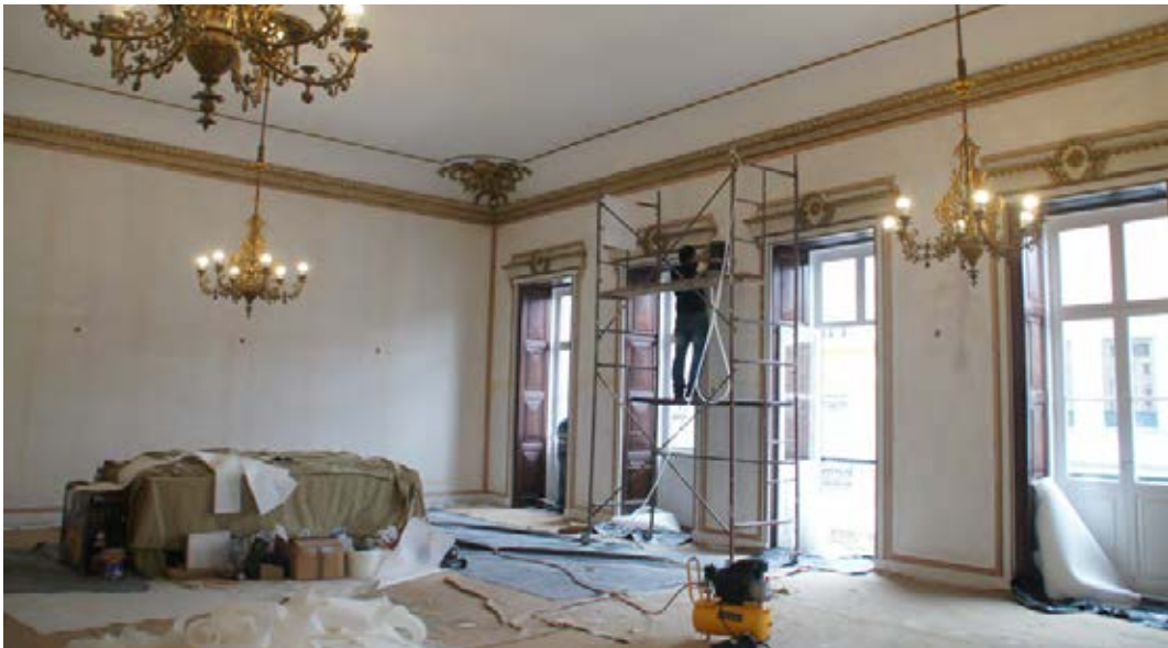
Obras de conservação e restauro no Salão Nobre (fotografia de Paulo Mendonça).
