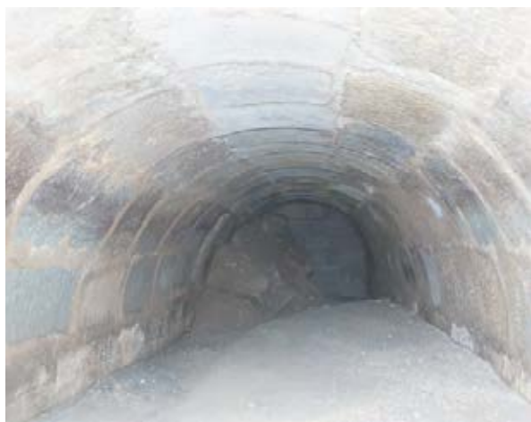
Túnel descoberto sob o edifício municipal.
