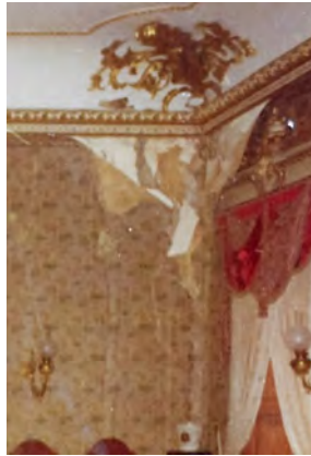
Pormenor da destruição do interior do Salão Nobre.
