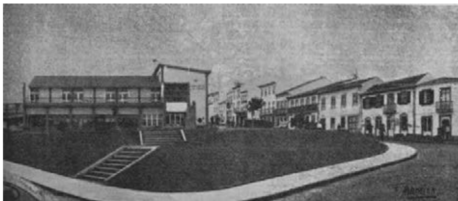
Do vazio formado pela demolição da antiga cadeia, obteve a Câmara Municipal esta elegante e moderna Praceta, vendo-se em frente o Quartel dos Bombeiros Voluntários, aberto em 7 de Setembro de 1969. Com as instalações da P. S. P., ocupadas em 7 de Setembro de 1974, e da Residencial Cruzeiro, inaugurada em 31 de Março de 1973, oferece airosa moldura urbana.
