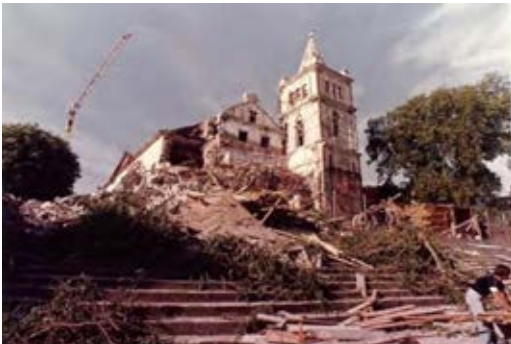
A igreja da Sé após o incêndio que a destruiu (Igreja Açores).
