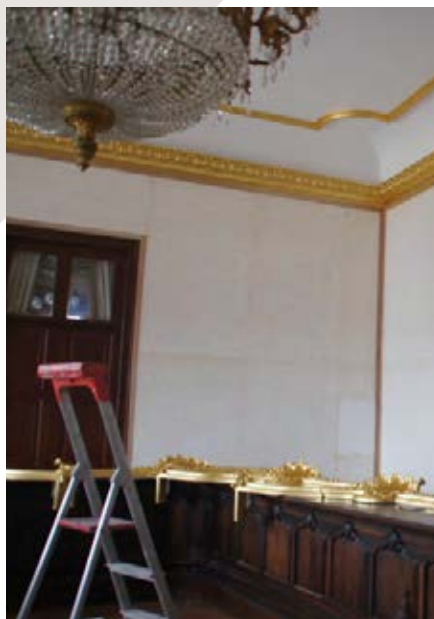
Sala de Sessões em obras de remodelação (fotografia de Paulo Mendonça).
