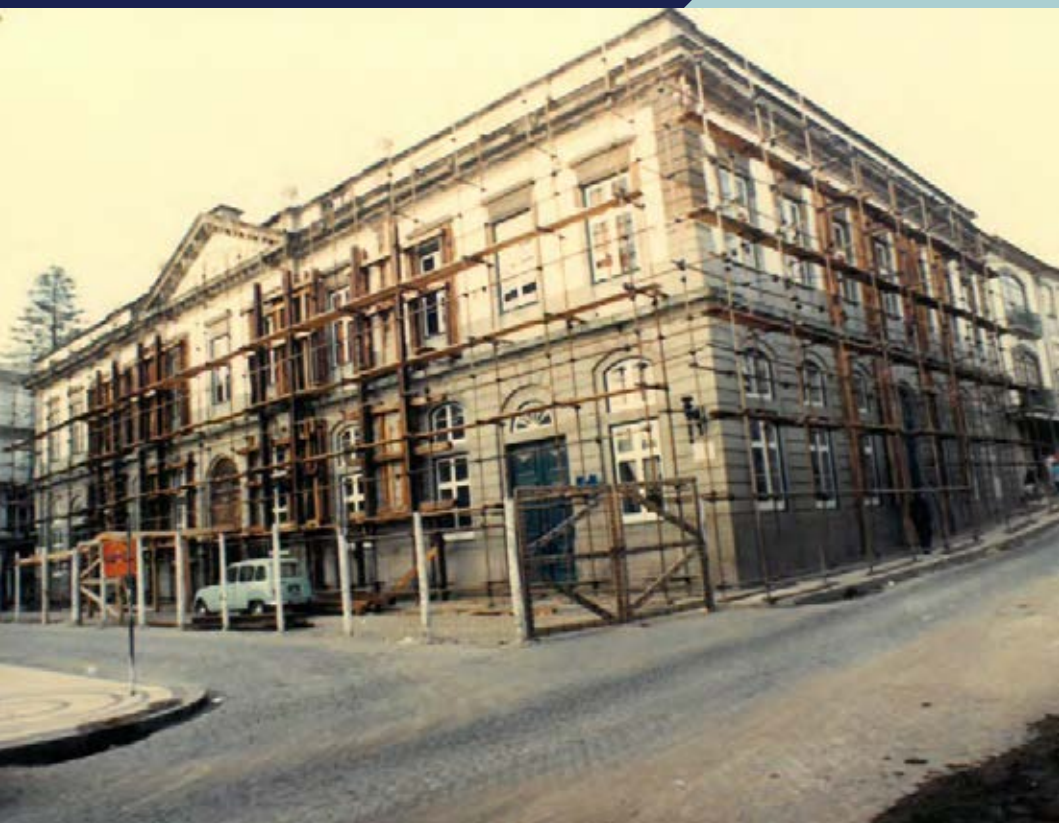
Câmara de Angra do Heroísmo em reconstrução.
