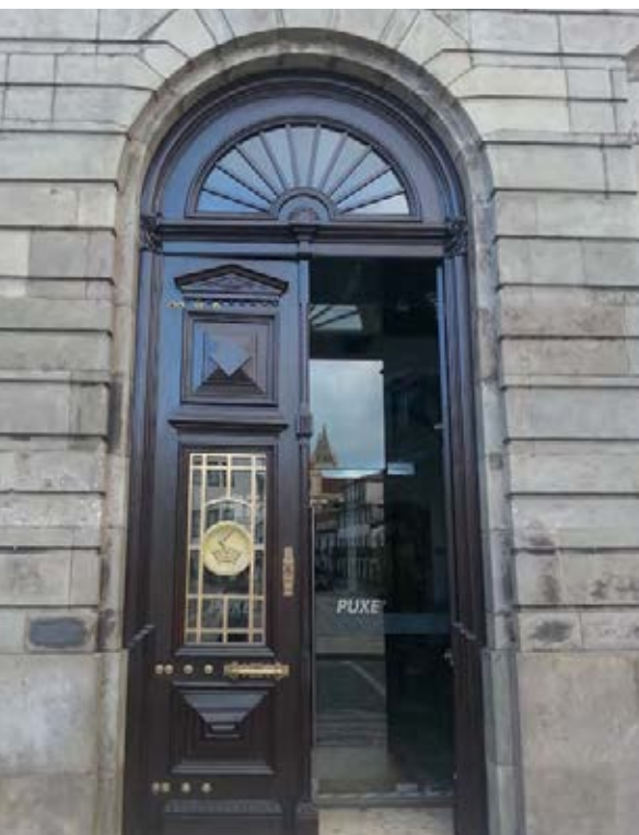
Porta de entrada da Câmara Municipal de Angra do Heroísmo e para-vento (Fotografia de Paulo Mendonça).
