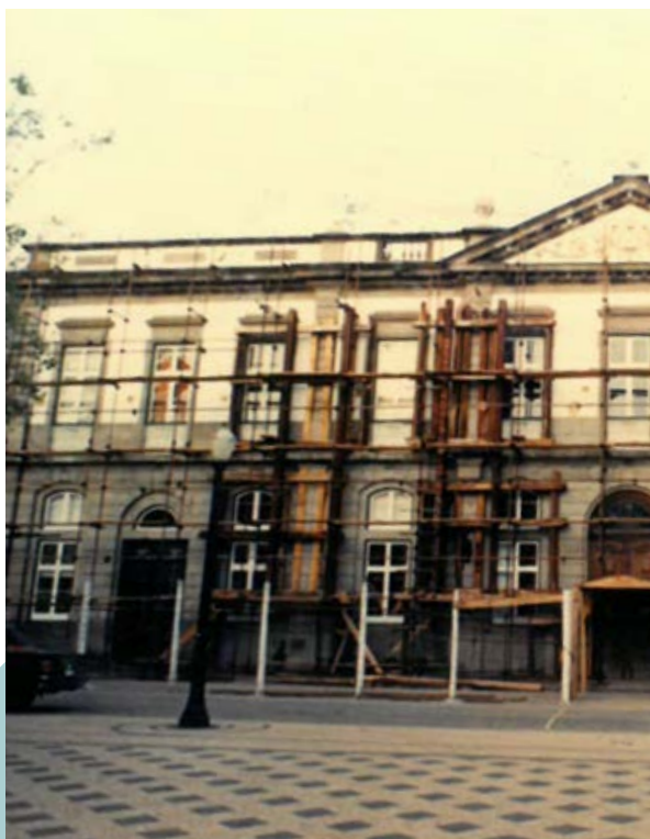
Câmara de Angra do Heroísmo em reconstrução.
